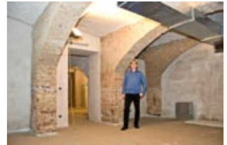
Im bereits fast fertig renovierten Gewölbe unter der Hauptschule präsentiert GGR Peter König die zukünftigen Räumlichkeiten des Jugendtreffs.
